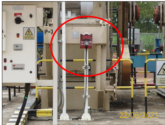
ภาพที่ 2.2-8 อุปกรณ์หยุดการทำงานฉุกเฉิน (OSD/ESD)
