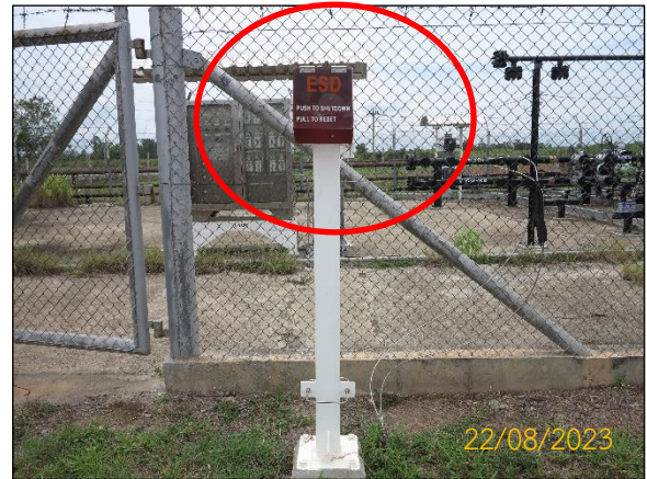
ภาพที่ 2.2-8 อุปกรณ์หยุดการทำงานฉุกเฉิน (OSD/ESD)
