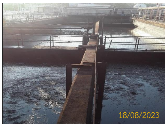
ภาพที่ 2.2-4 API Separator ที่สถานีผลิตลานกระบือ
